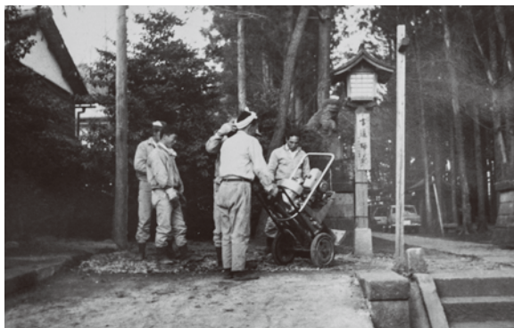
年代不明(階段上の工事)
